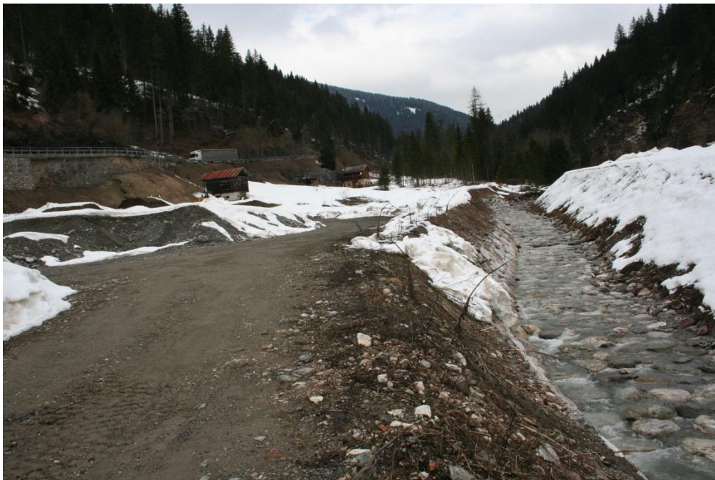
Fotografia n. 3 = L'area del previsto insediamento con la difesa arginale (da valle verso monte)
