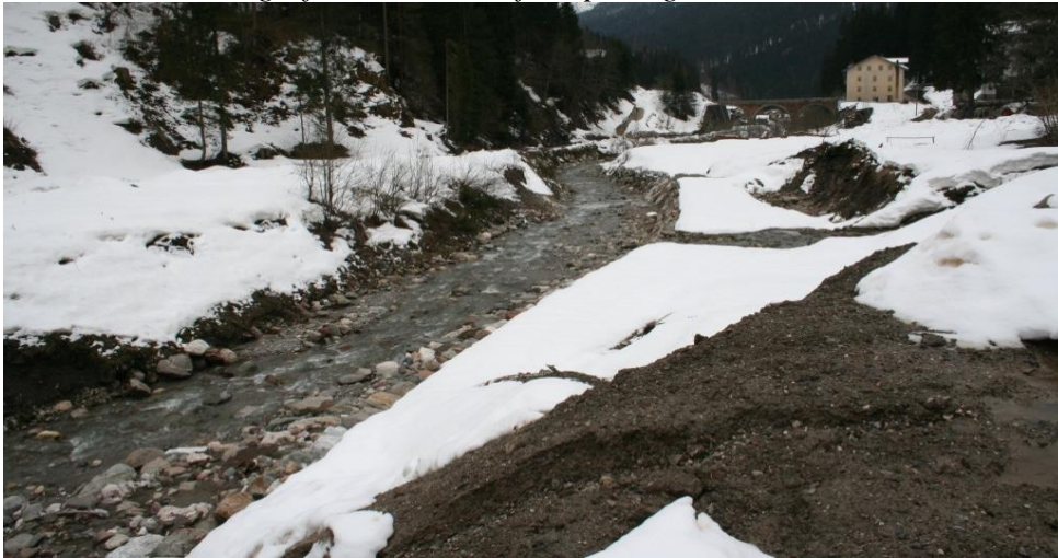
Fotografia n. 5 = La parte più a valle della difesa spondale
